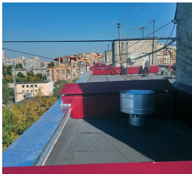
ул. Волочаевская, 15е, ремонт мягкой крыши
