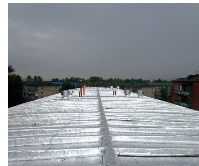
ул. 20-я Амурская, 20, ремонт мягкой крыши (материал «Ризолин»)
