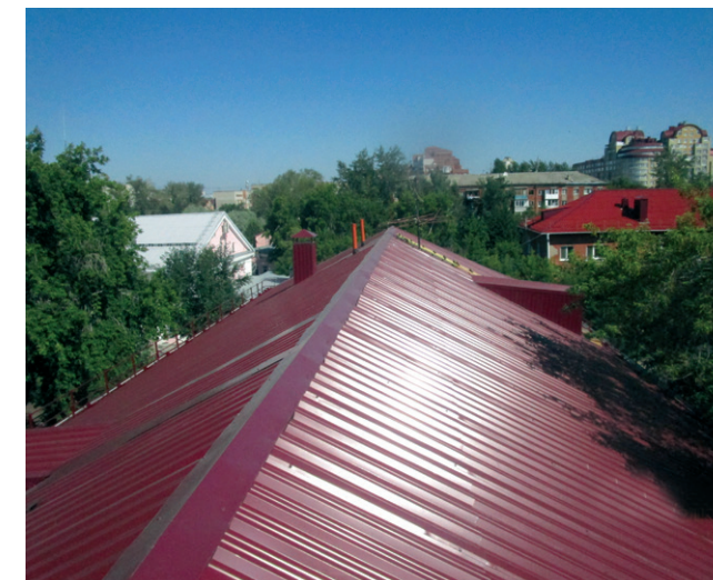
ул. Жукова, 152, ремонт крыши
