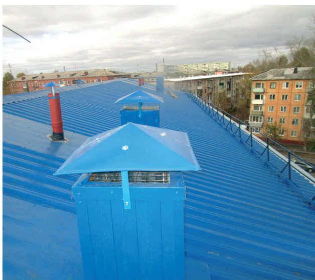
ул. 27-я Северная, 98, ремонт крыши
